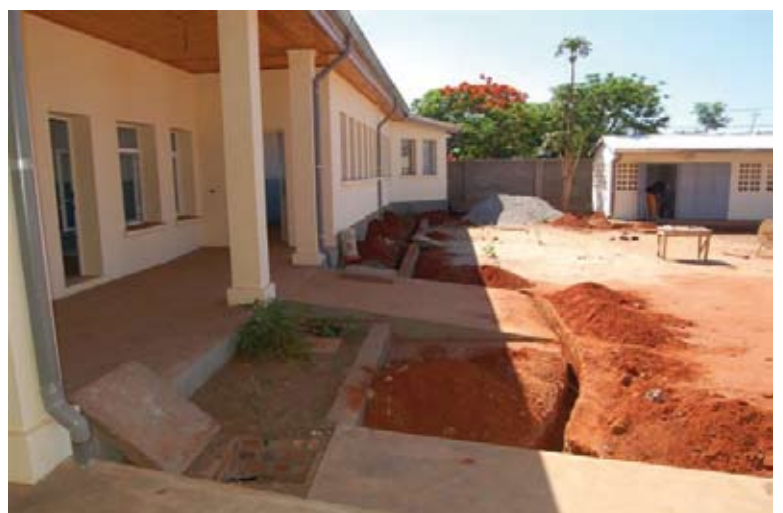
Lato frontale del nuovo Centro Sanitario di Ihosy
